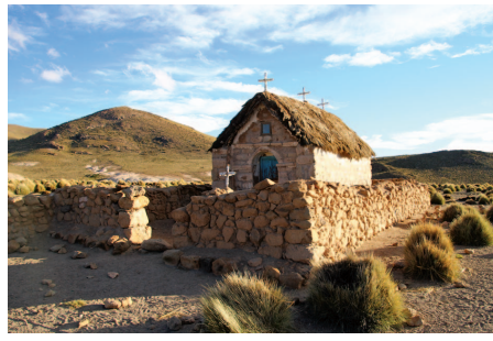
Fig. 1 (continuación) Las últimas dos iglesias patrimoniales del estudio: las de Guallatire y de Churiguaya.
